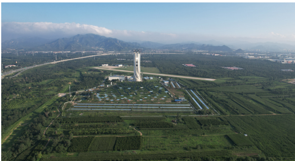
图 4.2-1 八达岭太阳能热发电实验电站（中国科学院电工研究所供图，2024 年 7 月 30 日）
